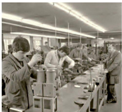
Lehrlinge fertigen 1982 im Werkzeugbau das Modell der 1. gasisolierten Schaltanlage WI
