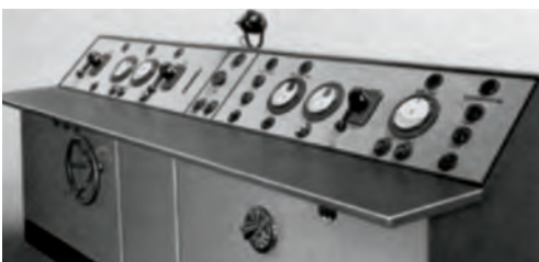
Neues Schaltpult fürs Prüffeld, angefertigt von geschickten Lehrlingen
