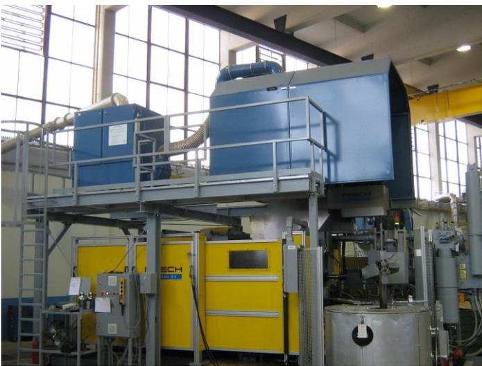
Öl- und Emulsionsnebelabscheider mit einem Volumenstrom von 8.000 m<sup>3</sup>/h zur Absaugung von Dämpfen, die beim Aluminiumdruckguss entstehen.
