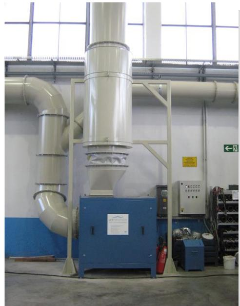
Die Anlage besteht aus mehreren Abscheidern mit einem zentralen Ventilator.
