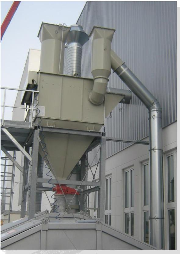
Patronenfilteranlage mit einem Volumenstrom von 12.000 m<sup>3</sup>/h zur Absaugung von Isolierstoffen, die beim Drehen von Isolatoren entstehen. Die Aufstellung der Filterzentrale erfolgt im Außenbereich mit Austrag über Zellenradschleusen in den beigeestellten Container. Diese Anlage beinhaltet ein Explosionsschutzkonzept mit gefahrloser Druckentlastung.
